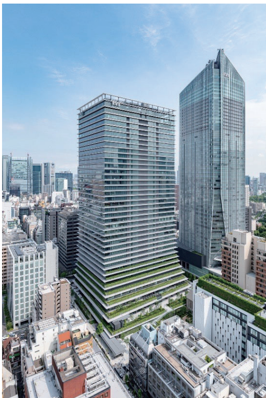
虎ノ門ヒルズビジネスタワー外観
