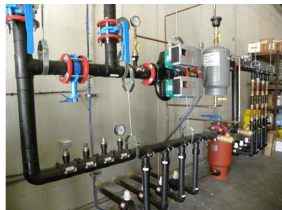
図 1 二重ポンプ水圧式分配システム図
