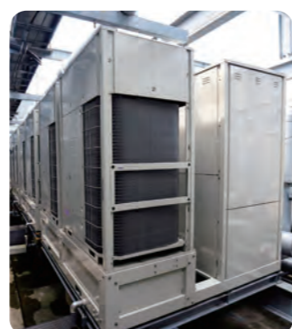
ビル屋上に新設された熱回収空冷式ヒートポンプアイスジェネレーター
