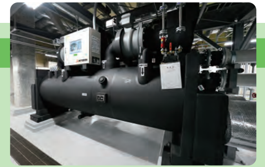
インバータターボ冷凍機
