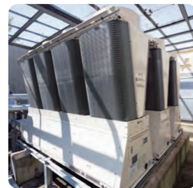
吸収式温水機に代わって新設された空冷式ヒートポンプチラー
