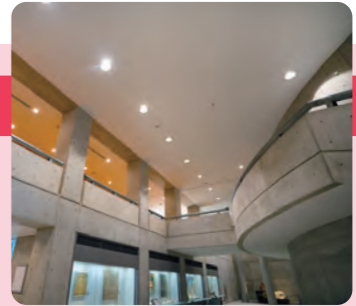
館内のLED照明
