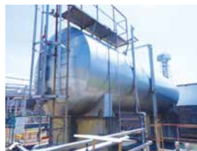
既設タンクを保温施工した温水槽 (47㎡)
