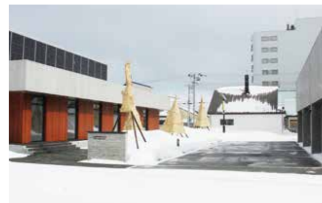
駐車スペースと通路の融雪に地中熱ヒートポンプシステムを採用。除雪の手間が軽減された
