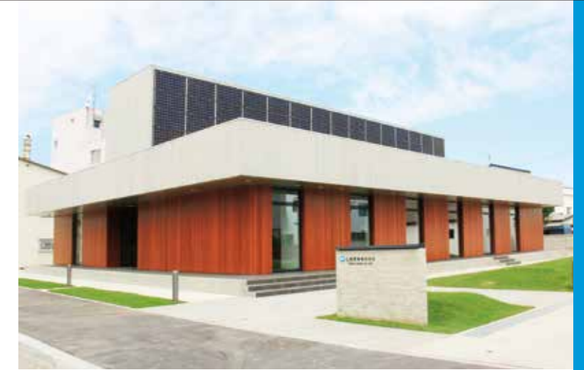
再生可能エネルギーを活用した新社屋はモダンなたたずまい
