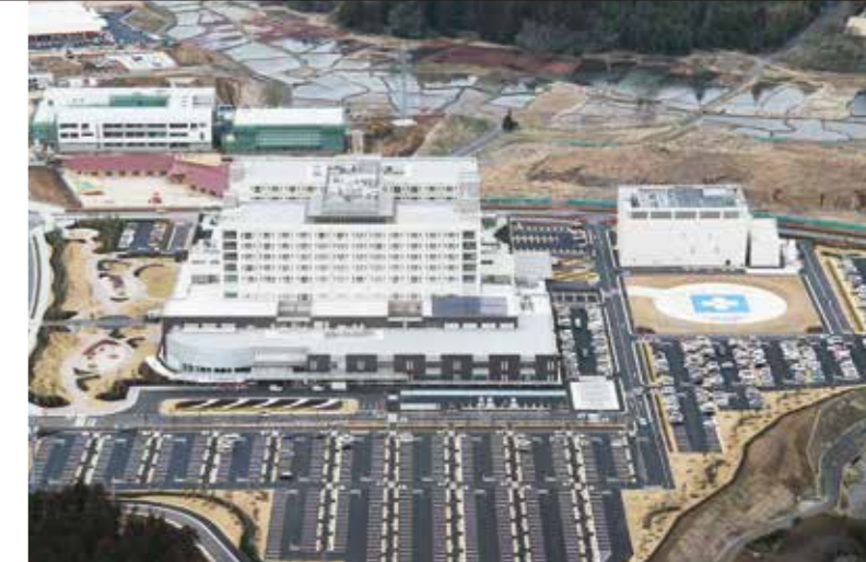
左が10階建ての病院棟、右が4階建てのエネルギー棟(エネルギー棟の右側が独立した躯体蓄熱槽)
