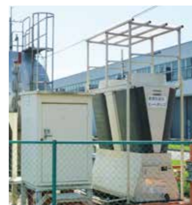
今回導入された循環加熱ヒートポンプ(70kW)。夜間電力の利用で効率よく温水を供給する
