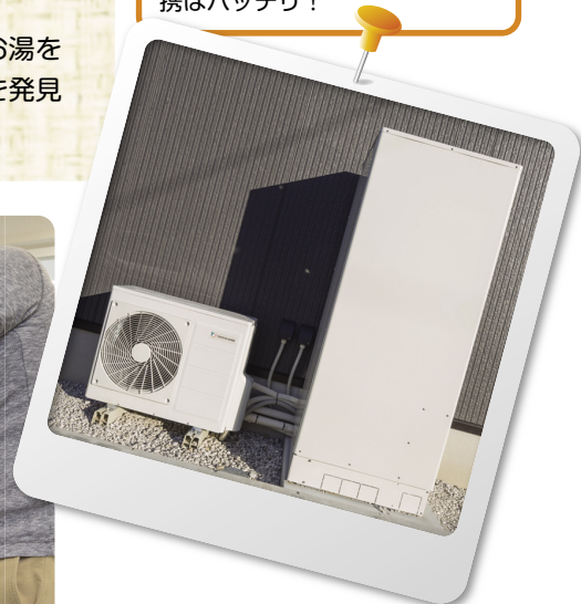
エコキュートの室外機とタンク。ご近所でもエコキュートを導入しているお宅は多いそう。
