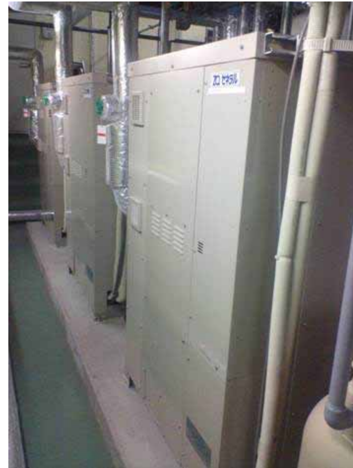
図 地中熱ビル用マルチ室外機
