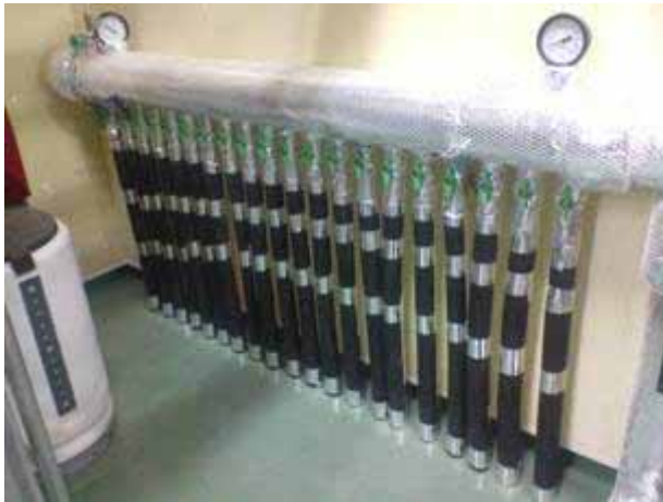
図 地中熱交換器(ヘッド部)
