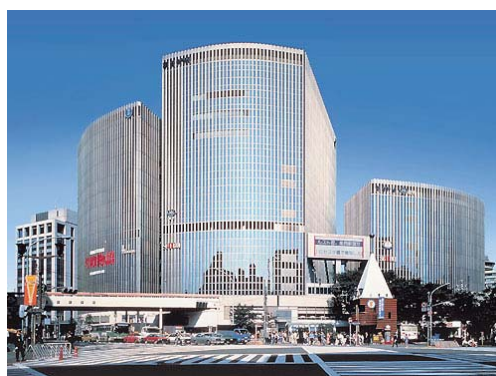
写真 3-1 Y C 施設外観
