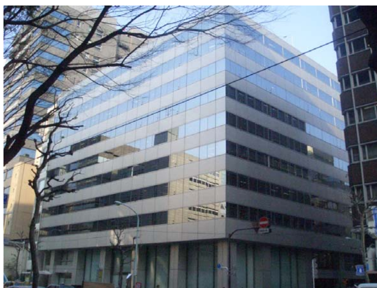
写真 4-1 HA施設外観
