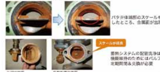
図-6,AHU運転変更とバルブリーク対策③ スケール
