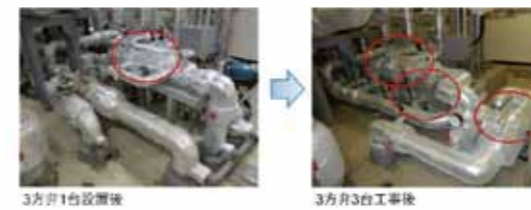
図-3,冷水温度安定化② 3方弁化工事
