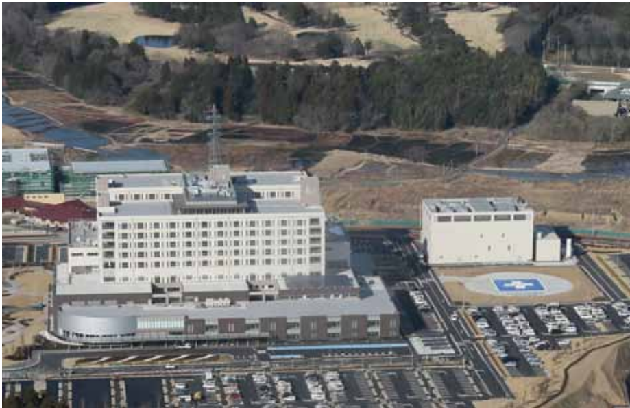
施設全景(左側:病院棟、右側:エネルギー棟)
