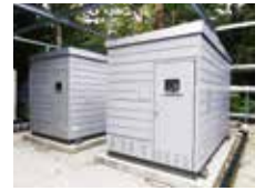
ガス焚吸収式冷温水機
