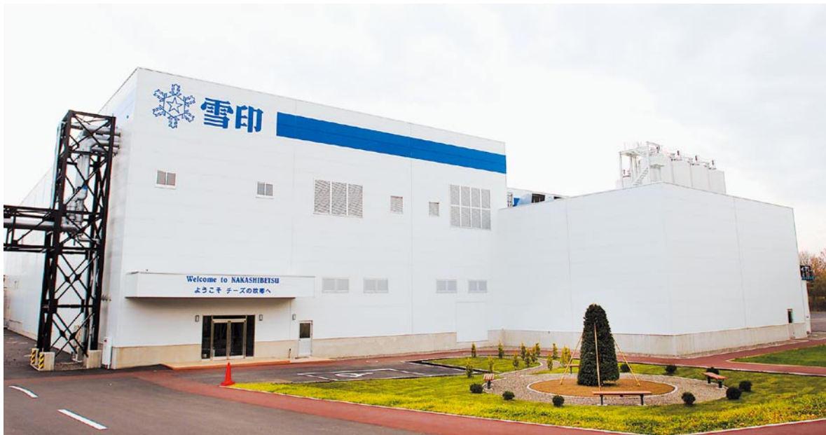
雪印乳業なかしべつ工場
