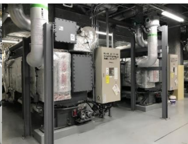
図4 ガス吸収式冷温水発生器
