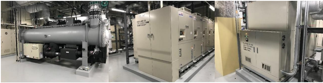
図5 ブラインターボ冷凍機
