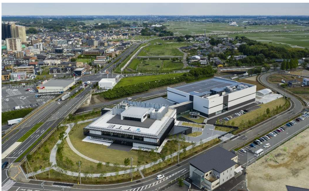
高砂熱学イノベーションセンター全景
