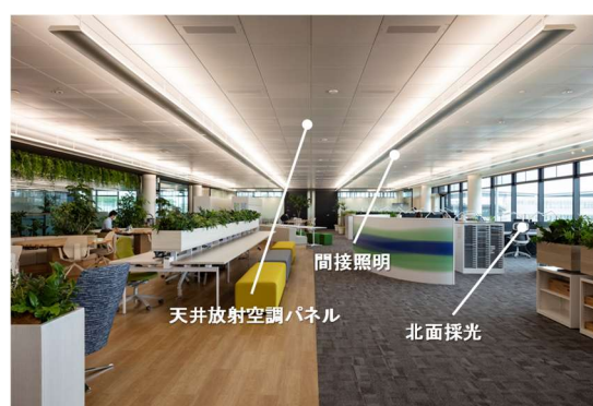
主執務室の間接照明システム
