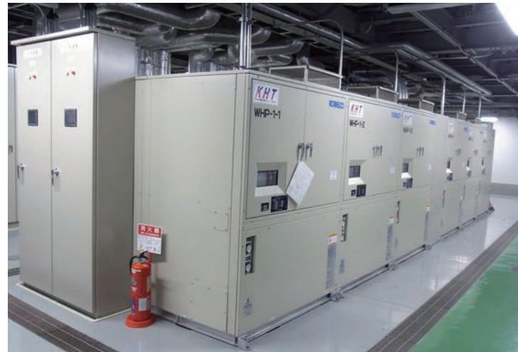
冷房排熱を捨てずに、ヒートポンプで回収してデシカント空調向けに有効利用することで全体の効率を高めている
