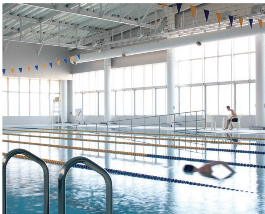
屋内温水プールの余熱が暖房代わりになったほか、緊急用浄水装置によってプールの水を飲料水として利用した
