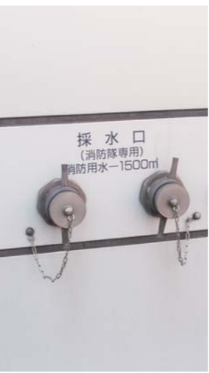
▲浸水防止板設置 ▲蓄熱槽点検口 ▲消防訓練時の放水風景 [出典：(一社)日本熱供給事業協会「熱供給」vol.69/2007号] ▲消防用採水口
