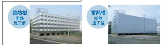
図1 蓄熱槽 断熱施工前・施工後
