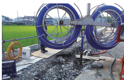
地中熱ボアホール挿入状況
