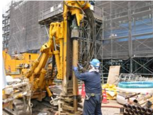
ケーシング引抜き
