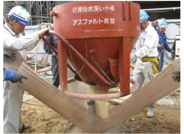
充填材注入(SIC配合)
