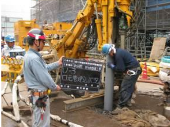
口元塩ビ管建込み
