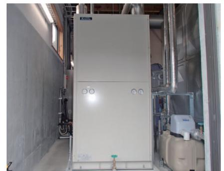
排熱回収給湯用ヒートポンプ
