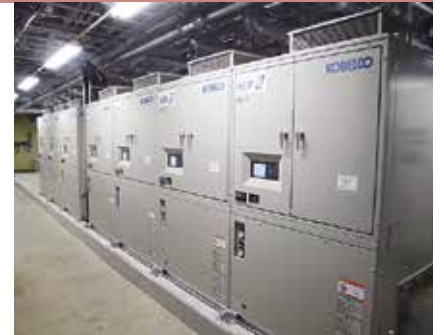
導入した水冷ヒートポンプチラー
