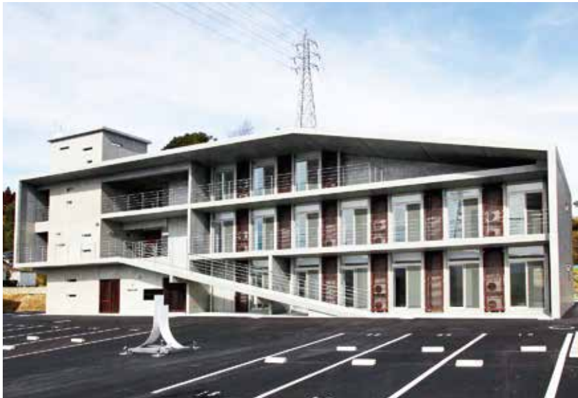
壁式鉄筋コンクリート造の川内寮
