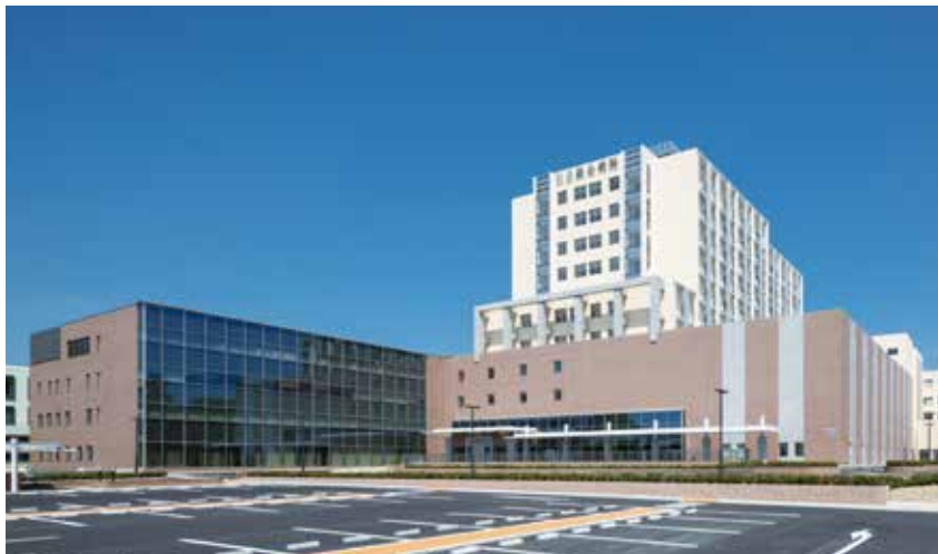
日立総合病院 本館棟
