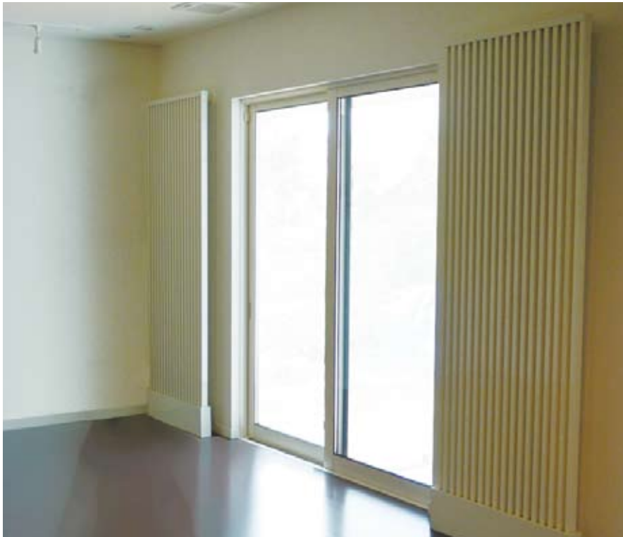
輻射パネルルーバー
