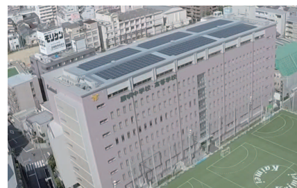
校舎屋上 太陽光パネル
