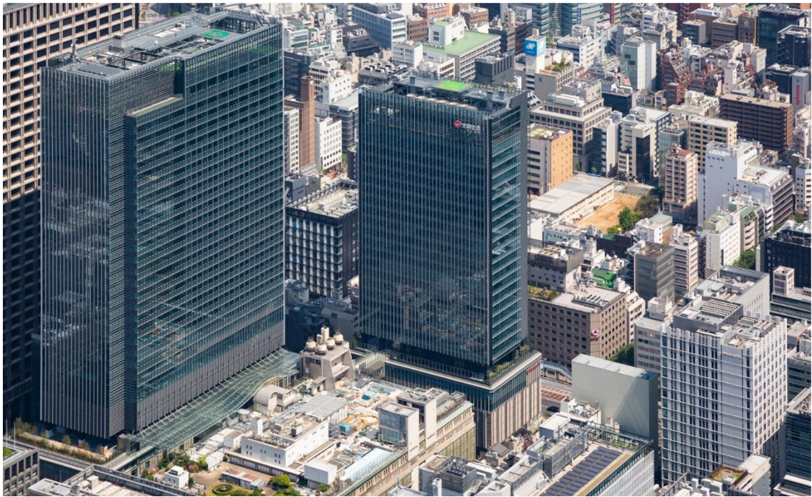
日本橋二丁目地区全景
