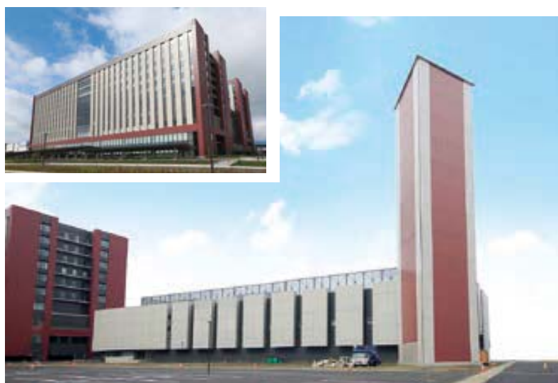
岩手医科大学付属病院エネルギーセンター (写真は岩手医科大学付属病院様のHPから引用)
