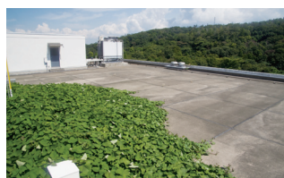
上) 新たに導入したターボ冷凍機 下) サツマイモ栽培による屋上緑化。断熱効果で省エネルギー化を図る
