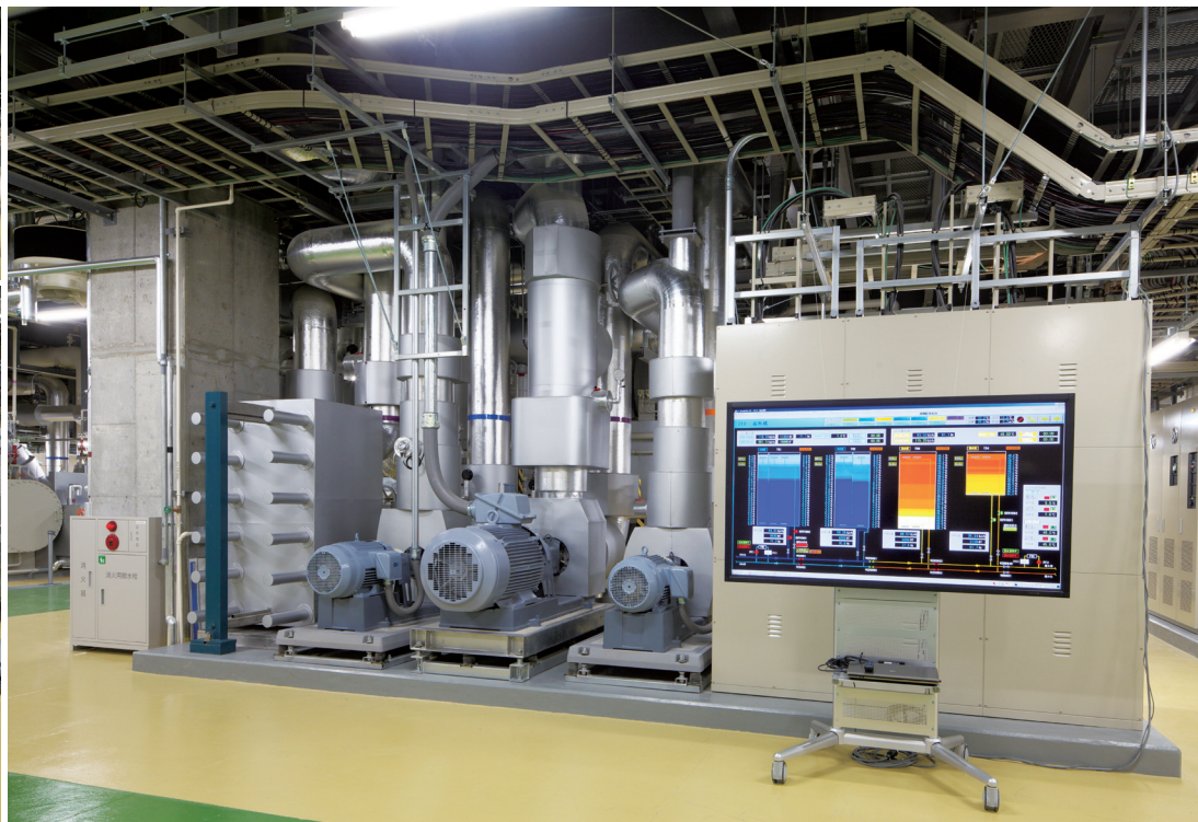
メインプラントの内部は「見える化」設備も充実。蓄熱槽の温度状況なども手に取るようにわかり、非常に興味深い
