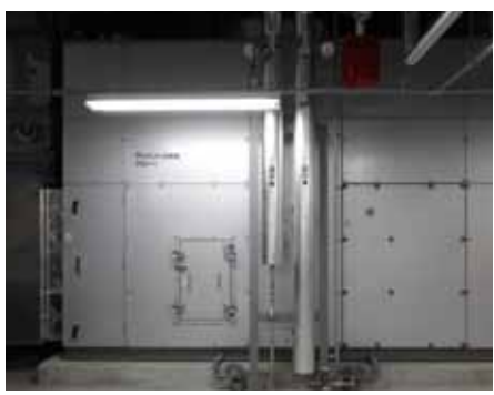
上)空気熱源ヒートポンプチャラー 加熱能力:54.3kW×13台[三菱電機] ヒートポンプ給湯機 加熱能力:49.3kW×2台[三菱電機] 中)貯湯槽15m 3 ×1基 下)デシカント空調機×1基
