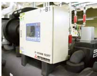
(写真) インバーターボ冷凍機527kW[三菱重工]
