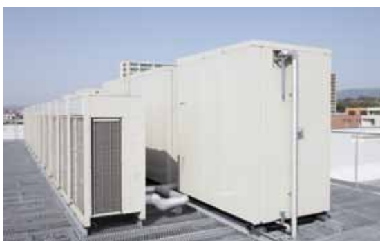
上)地中熱利用水熱源ヒートポンプ 527kW×1台[神戸製鋼所] 中)モジュール型 空気熱源ヒートポンプチャラー 475kW(5モジュール) [東芝キヤリア] 下)全パッケージ (氷蓄熱ユニット エコ・アイス含む) 1,500kW[ダイキン工業]
