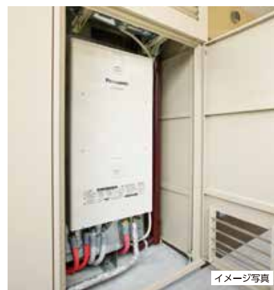
メータBOX内下部に設置された貯湯タンク(ヒートポンプは上部)
