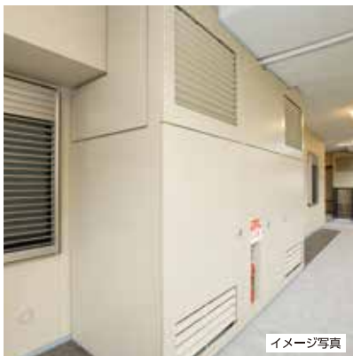
貯湯タンクとヒートポンプを廊下側メータBOX内に縦2段に設置
