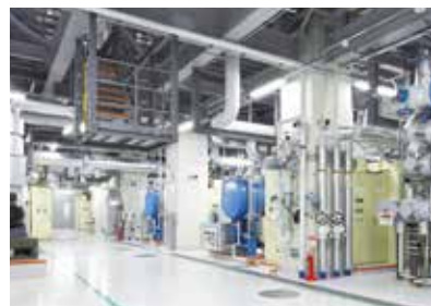
インバーターボ冷凍機 写真撮影:株式会社ミヤガワ
