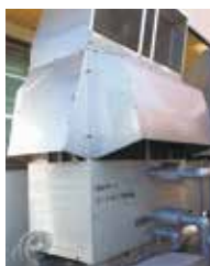
ヒートポンプ給湯機
