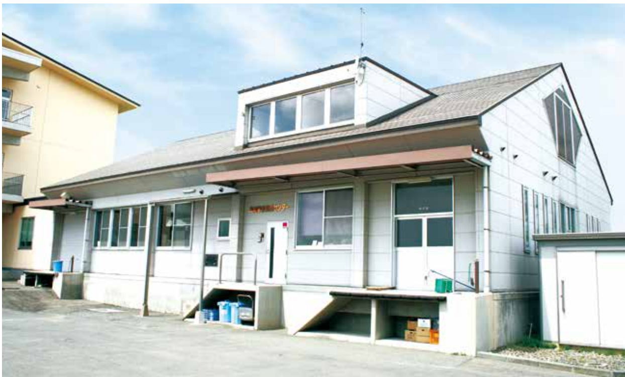
奥州市立真城学校給食センター
