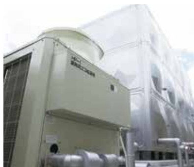
業務用エコキュートと貯湯槽
