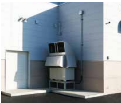
業務用エコキュート室外機
