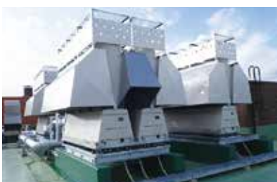
寒冷地対応空冷ヒートポンプチャラー
