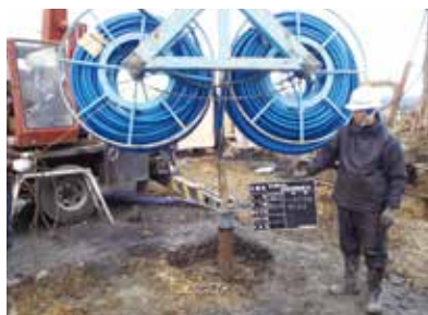
地中熱交換器設置
