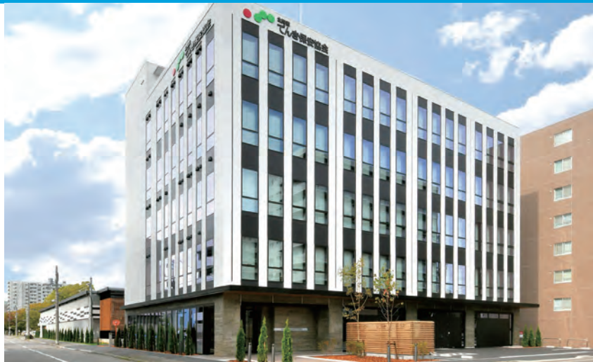
北海道電気保安協会 札幌中央事務所
