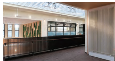
除湿型冷暖房輻射熱パネル
