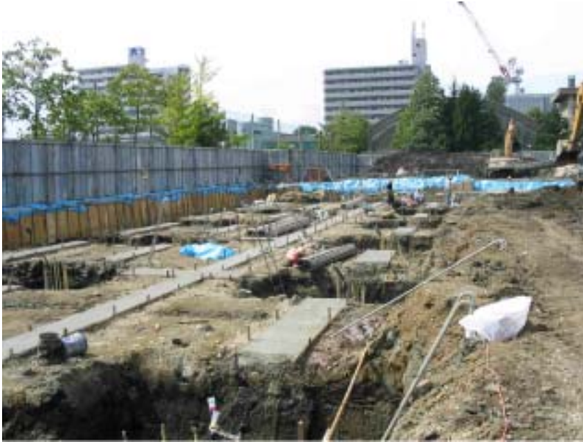
熱交換井(基礎杭)設置風景
