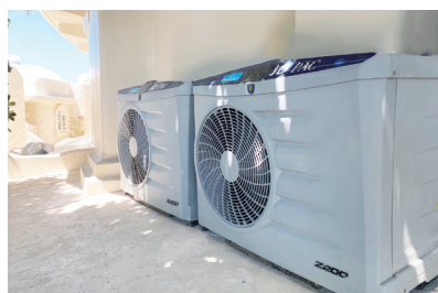
業務用ヒートポンプ給湯機室外機
