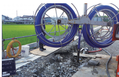
地中熱ボアホール挿入状況
