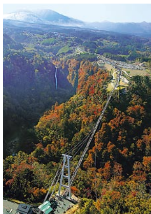
九重「夢」大吊橋
