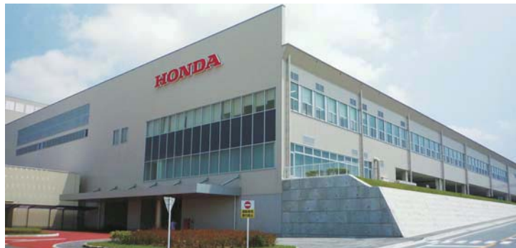
本田技研工業 熊本製作所 完成車工場
