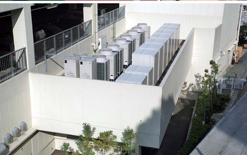
屋上駐車場（上）と駐車場へのアプローチ通路脇などに配置された冷凍機、蓄熱槽
