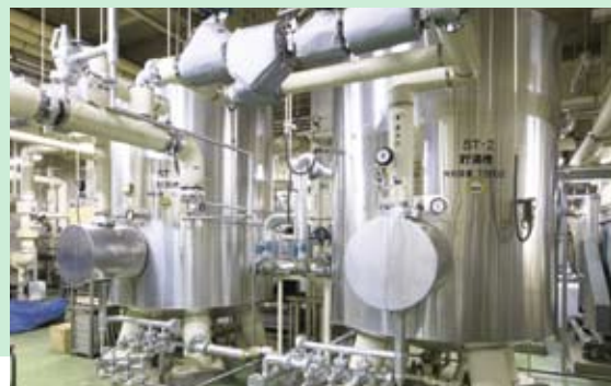
蒸気ボイラーの 貯湯槽
