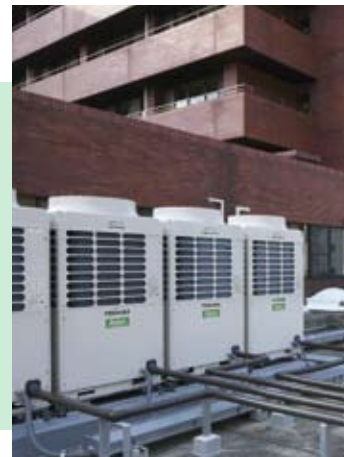
空気熱源ヒートポンプエアコン (ビル用マルチ) 室外機
