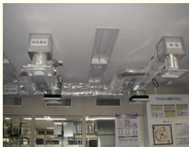
スモークで空気の流れを体感できる各種空調吹き出し口
