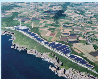
宮古メガソーラー実証研究設備
