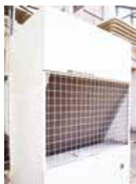
左)業務用エコキュート(密閉対応) 40kW×5台[三菱電機]
