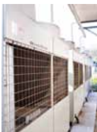
右)循環加温型ヒートポンプ52.6kW×5台[三菱電機]
