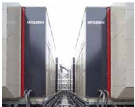
上) 氷蓄熱槽276m 3 中) ブラインターボ冷凍機 396USRT×1基[荏原冷熱システム] 下) 空気熱源ヒートポンプチャラー 48USRT×32台[三菱電機]
