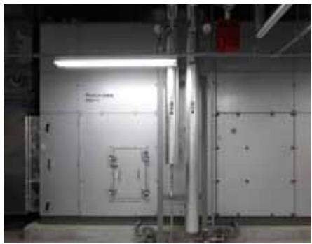
上)空気熱源ヒートポンプチャラー 加熱能力:54.3kW×13台[三菱電機] ヒートポンプ給湯機 加熱能力:49.3kW×2台[三菱電機] 中)貯湯槽15m×1基 下)デシカント空調機×1基
